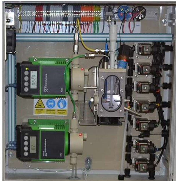
Figura 36: La celda de medición montada en posición
